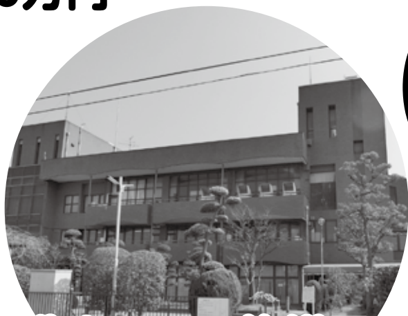
文化センター修繕工事 7,790万円
