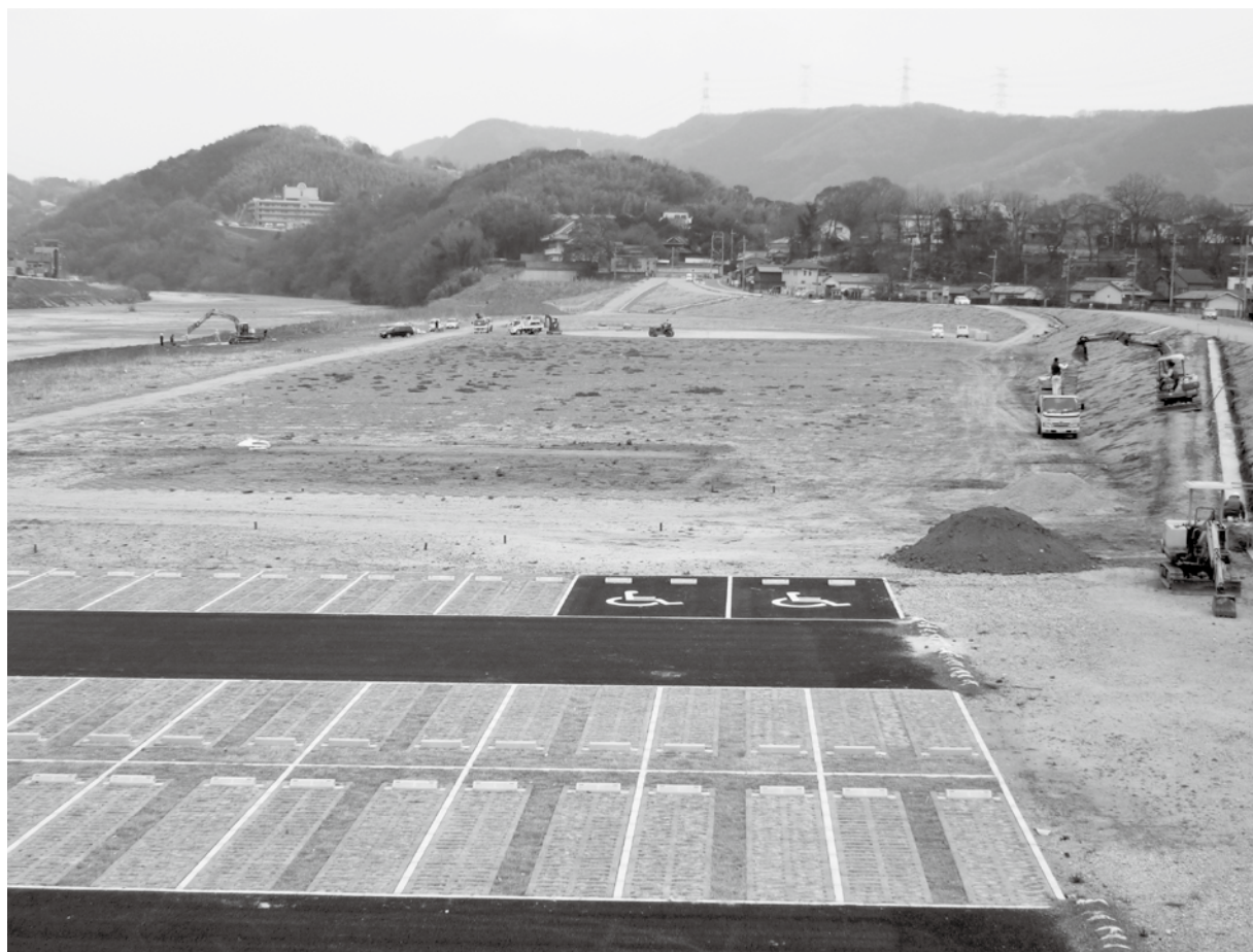
工事中の大和川親水公園
