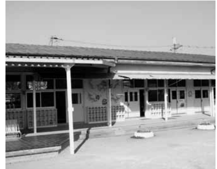
施設整備が待たれる幼稚園（柏原西幼稚園）
