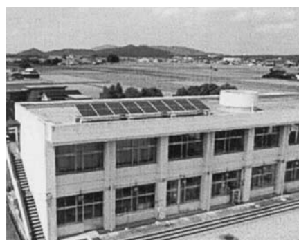
校舎屋上太陽光発電設備（他市）
