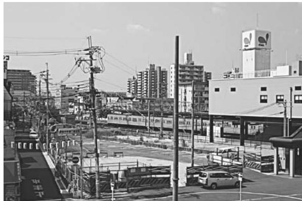
駐車場建設予定地（通称三角地）
