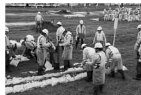
積み土のう作業の様子
