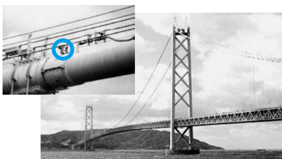
明石海峡大橋に取り付けられている同社の超微圧用安全弁
