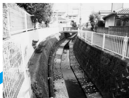
改修が終わった工事区間
