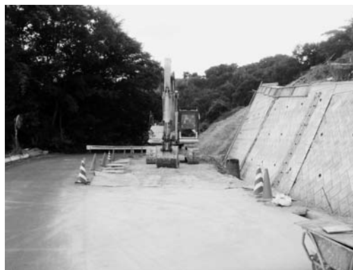
拡幅工事中です(8月5日撮影)
