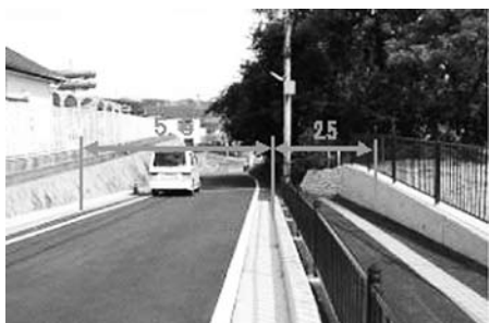
すでに完成した歩道の部分
