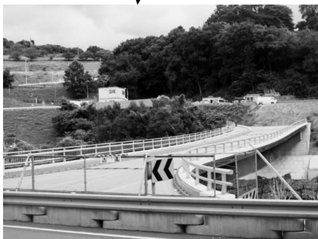
整備が進む「新亀の瀬橋」
