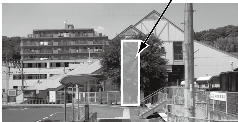
構外エレベーター設置
