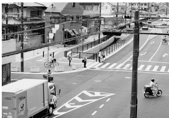
完成した上市今町線（平野川沿いの道路）
