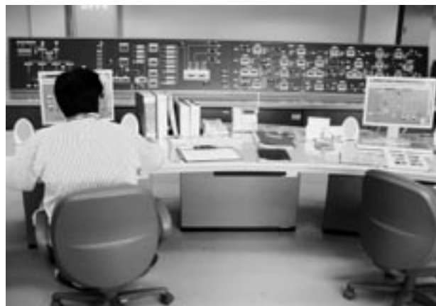
中央監視設備を更新
