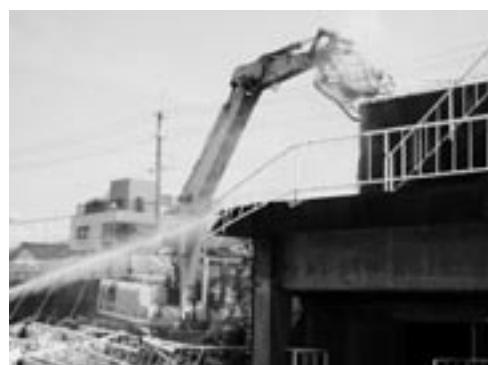
旧浄水施設の解体工事
