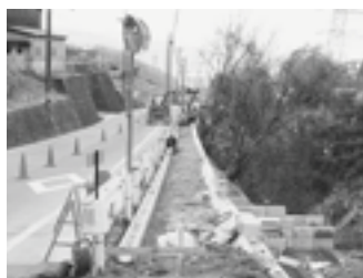
歩道整備中の様子
