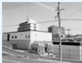
玉手浄水場外観
