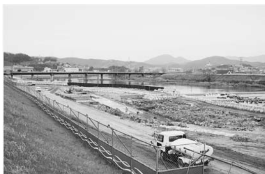
柏原えん堤魚道の工事状況（平成21年2月）
