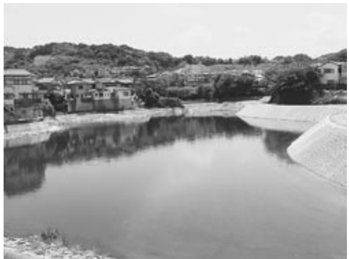
現在の田辺池の状況です。秋ごろから工事を再開します
