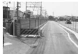
法善寺駅南側線路沿いの道路の新設
