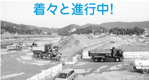
大和川河川事務所（国）により大和川国分付近の国豊橋上流河川敷の改修工事が着々と進められています。現在、取り壊されたガラの撤去や堤防を強化する盛土工事、河川敷の掘削工事などが行われており、平成21年度末の完了後には、3万㎡余りの河川敷公園として生まれ変わります。
