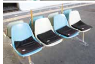
近鉄河内国分駅での設置作業
