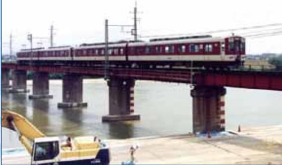
柏原の名物風景であり、撮り鉄、の人気スポットでもある、近鉄道明寺線の大和川橋梁を走る2両編成の電車。実は17年前（平成11年）のちょうど今ごろ、約2週間、全面運休していた期間がありましたw(°o°)w 記録的な豪雨による大和川増水の影響で、10本の橋脚のうち柏原南口側から3番目の橋脚が上流側に大きく傾いたためです。その後復旧工事…
