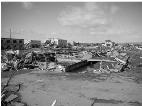
基礎部分以外全て流された閑上保育所跡地
