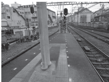
幅が狭くなっているホーム
