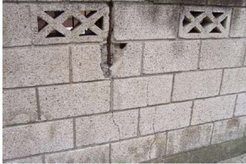
塀に大きなひび割れが生じている
