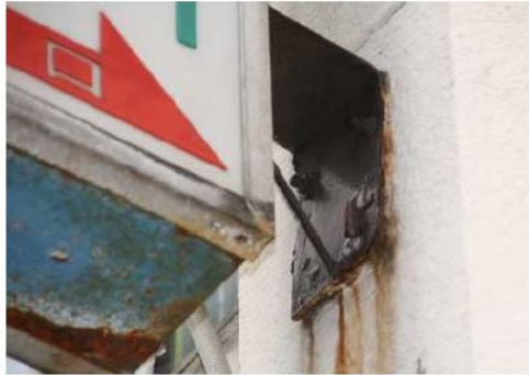
支持部分に著しい腐食が生じている
