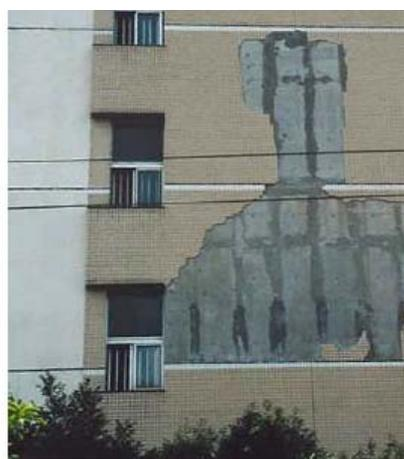
外壁に脱落が生じている
