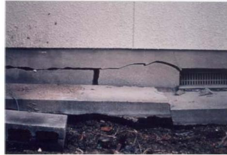
基礎が大きく破損している
