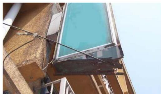
底板に腐食が生じている
