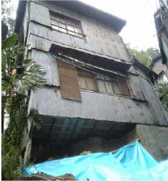
基礎が大きく欠損している
