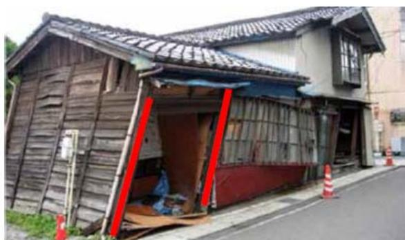
外壁が大きく傾斜しており、建具や窓枠がはずれ、原型を留めていない
