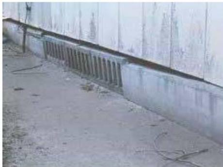
基礎が沈下し破損している
