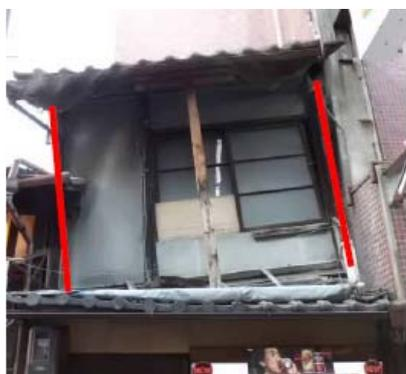
2階部分が沈み込み全体的に傾斜している
