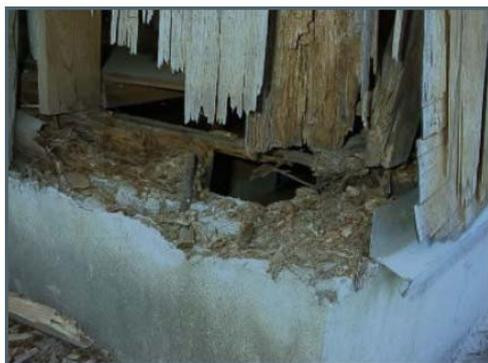
蟻害が発生し欠損している
