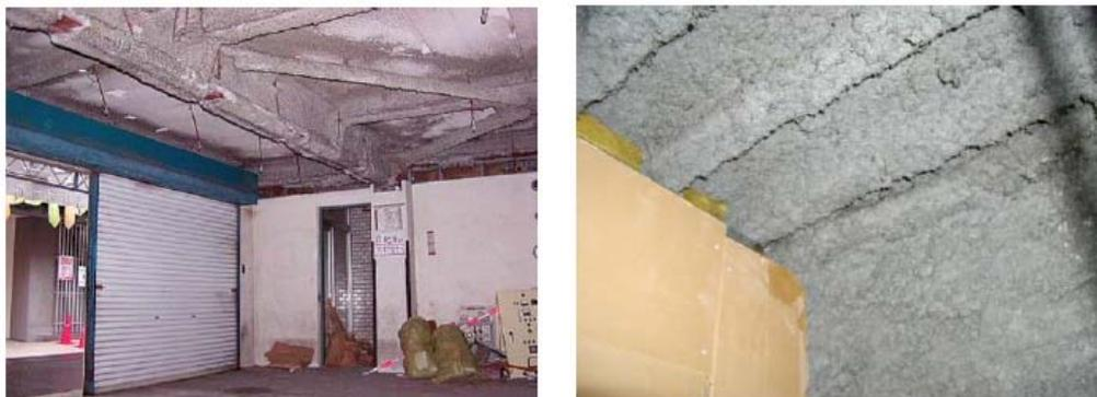
吹付アスベストなどが飛散し、暴露する可能性が高い
