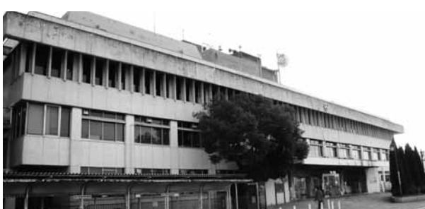
現在使用されている庁舎
