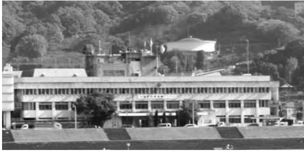
対岸から見た庁舎の様子
