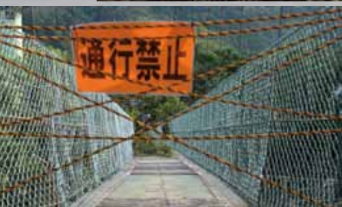
流木により通行禁止となった川端橋。
