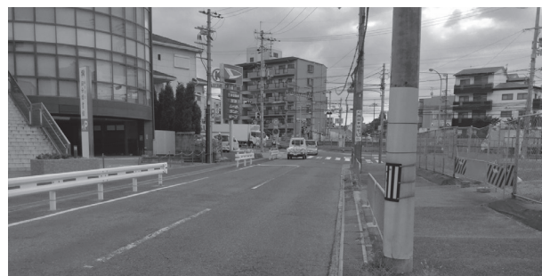
東西を結ぶための田辺旭ヶ丘線
