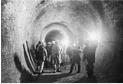
トンネルは高さ 4.6 m、幅 4.3m の馬てい形
