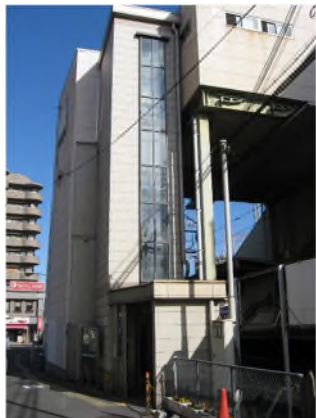
河内国分駅西口 エレベーター整備
