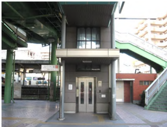
河内国分駅東口 エレベーター整備
