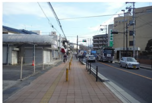
国道25号(整備後)
