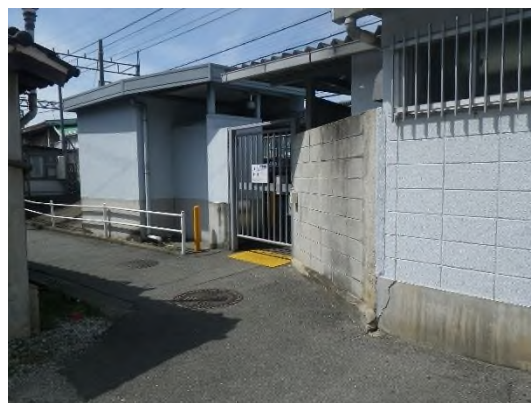
写真：堅下駅優先出入口
