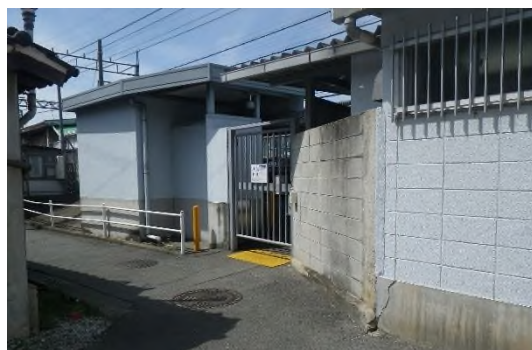
写真：堅下駅優先出入口
