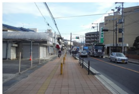
国道25号（整備後）
