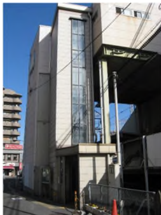
河内国分駅西口 エレベーター整備
