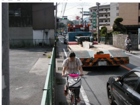
国道25号（整備前）
