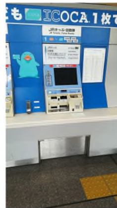
JR 柏原駅 券売機カウンター改修
