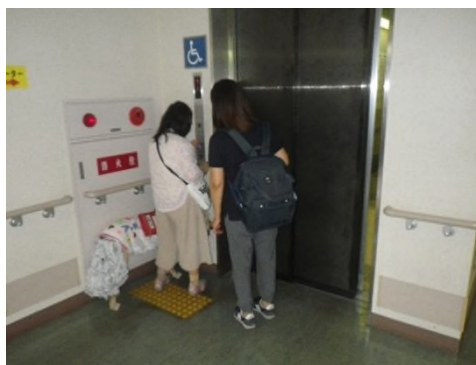
D エレベーター
