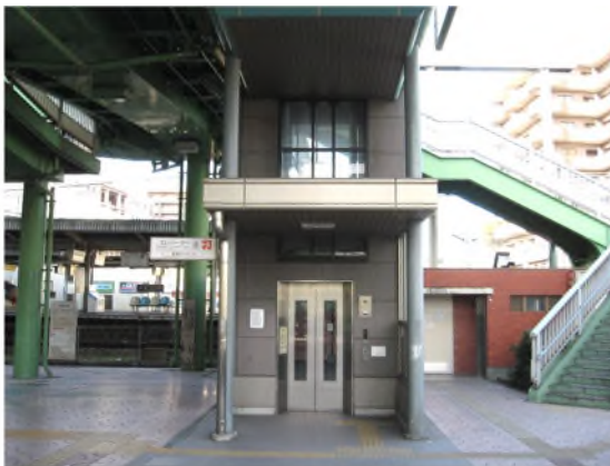
河内国分駅東口 エレベーター整備
