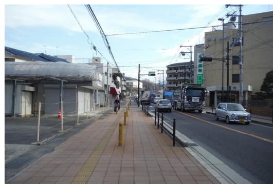
国道25号（整備後）
