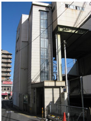
河内国分駅西口 エレベーター整備
