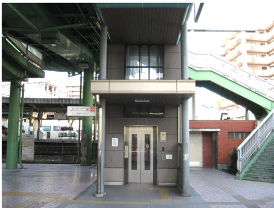
河内国分駅東口 エレベーター整備
