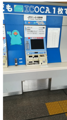
JR 柏原駅 券売機カウンター改修
