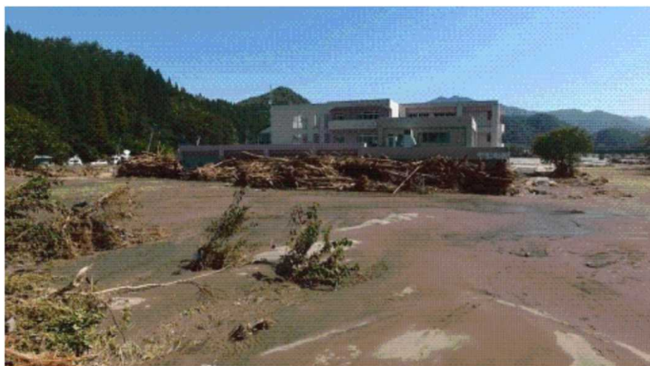
平成28年台風第10号による被害状況
