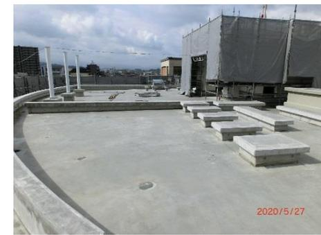
屋上と2階内部です。屋上のコンクリート打設が完了しました。各階、耐火・断熱・吸音性に優れるよう岩綿吹付・ウレタン吹付が行われました。また、1～3階にはエアコン吊込み、空調配管がされました。
