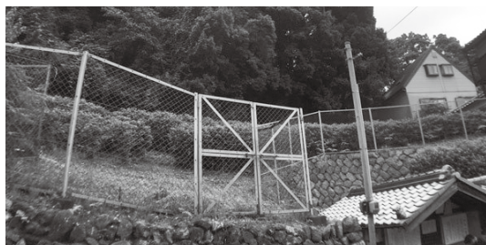
〈斜面保護対策工事予定地〉
