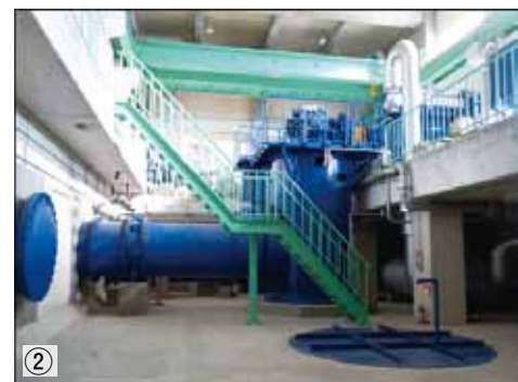
▲（図1）ポンプ施設から河川へ強制排水
