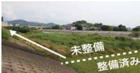
大和川水管橋から上流の未整備河川敷
