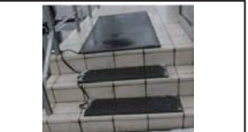
従業員通路への凍結防止装置の導入
