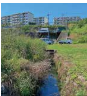
▲田輪樋 入口付近
