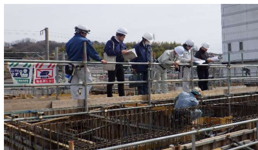
②型枠・鉄筋組み立て検査状況
