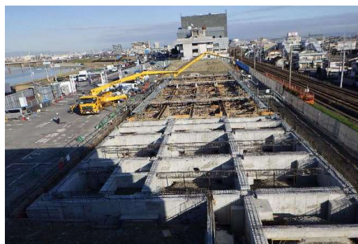
コンクリート打設後
