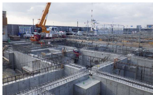
④基礎型枠脱型状況
