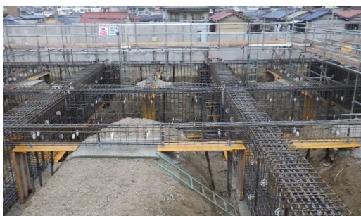
①鉄筋工事状況
