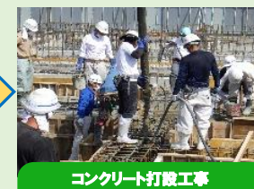
コンクリート打設工事
