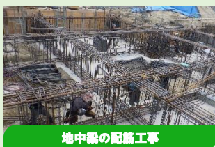
地中梁の配筋工事
