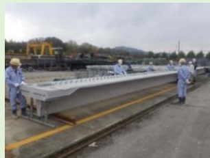
■コンクリート打設後のプレキャスト床版の寸法検査
