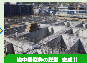
地中梁型枠の脱型 完成！！
