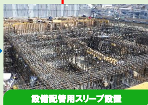
設備配管用スリーブ設置
