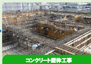
コンクリート型枠工事
