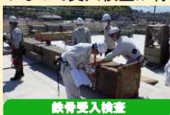
鉄骨受入検査
