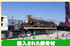
搬入された鉄骨材
