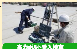
高力ボルト受入検査
