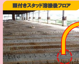
頭付きスタッド溶接後フロア
