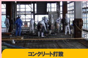
コンクリート打設
