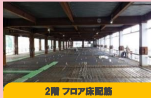
2階 フロア床配筋
