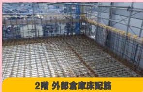
2階 外部倉庫床配筋
