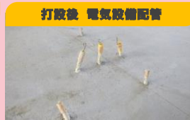
打設後 電気設備配管
