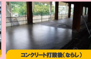
コンクリート打設後(ならし)
