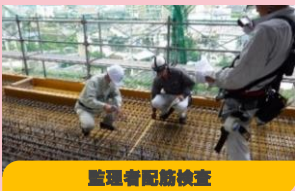
監理者配筋検査
