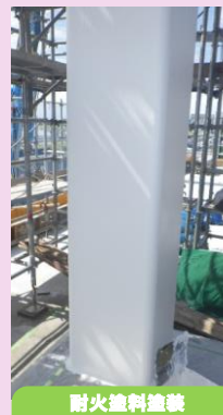
耐火塗料塗装
