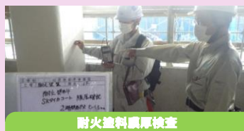
耐火塗料膜厚検査
