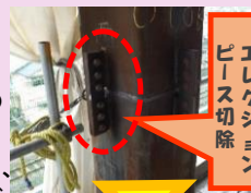
切除・溶接部分の研磨
