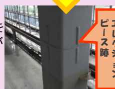
切除・溶接部分の研磨
