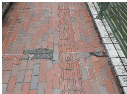
目地部付近の損傷及び補修跡
