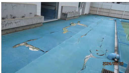
参考写真 柏原東小学校プール状況（2024.5.20撮影）
