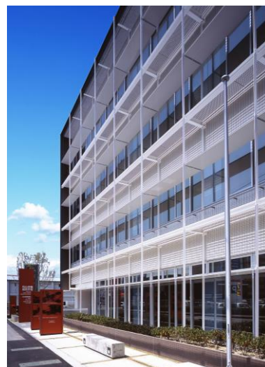
図 4-20 パッシブデザイン (自然光を取り込む ライトシェルフ) の例
