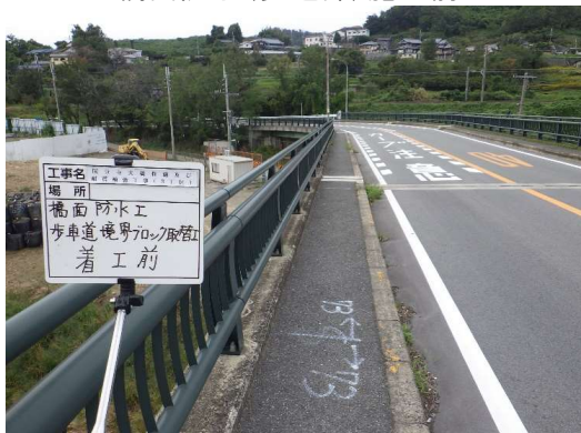
橋面防水(歩道部) 施工前
