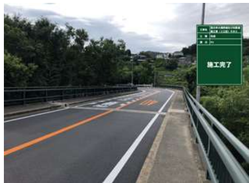
橋面防水(車道部) 施工後
