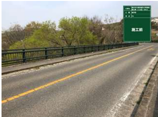
橋面防水(車道部) 施工前
