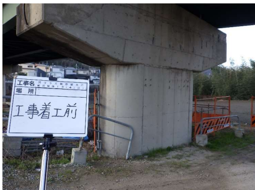
P4橋脚施工前
