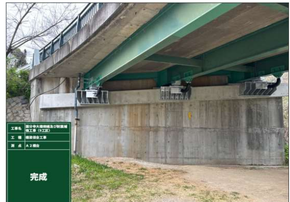
落橋防止装置（その2） 施工後
