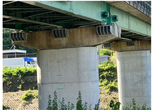
落橋防止装置（その1） 施工後
