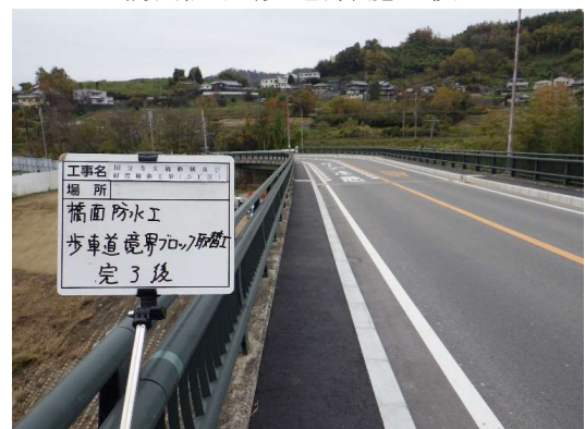
橋面防水(歩道部) 施工後
