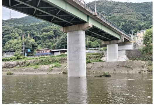
P2橋脚施工後
