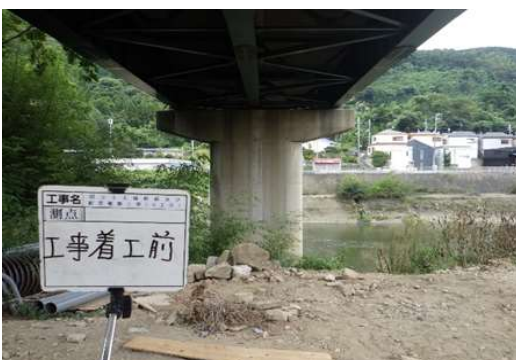
P3橋脚施工前
