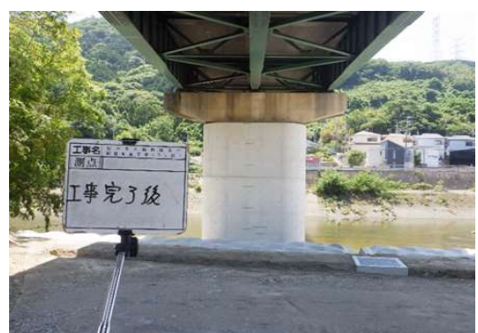
P3橋脚施工後
