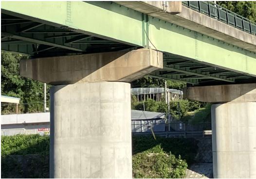
落橋防止装置（その1） 施工前
