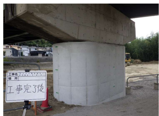
P4橋脚施工後
