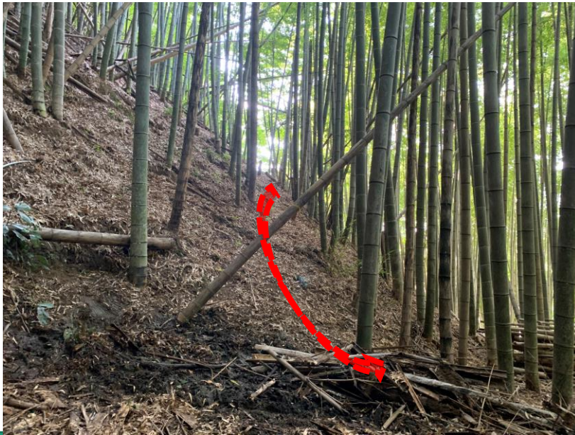
斜面に鍬で水平に段切りをする
