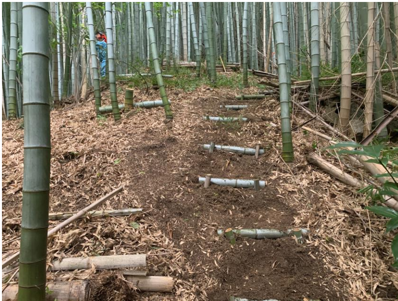
斜面に鍬で水平に段切りをする
