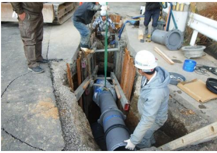
管路の更新・耐震化
