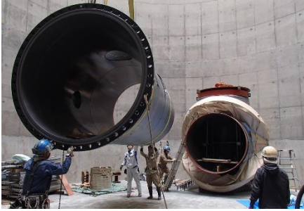
事故時におけるバックアップ機能の向上（バイパス送水管の整備）
