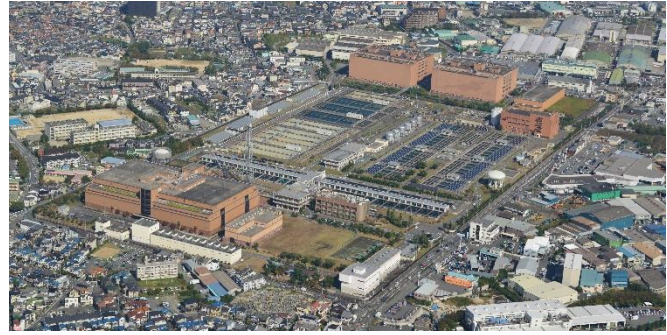
▲大阪広域水道企業団村野浄水場
