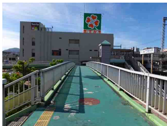
大規模な横断歩道橋（例：河内国分駅東口歩道橋）
