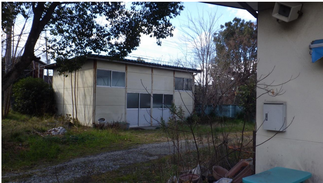
④倉庫（東方より）
