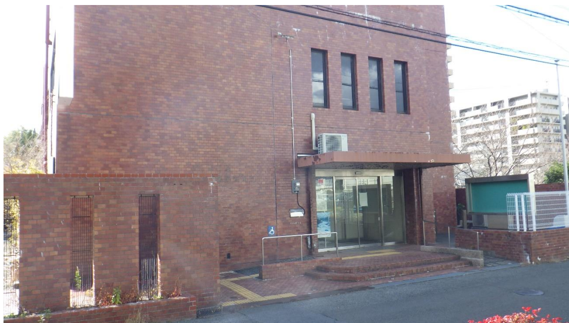
②正面玄関（東方より）
