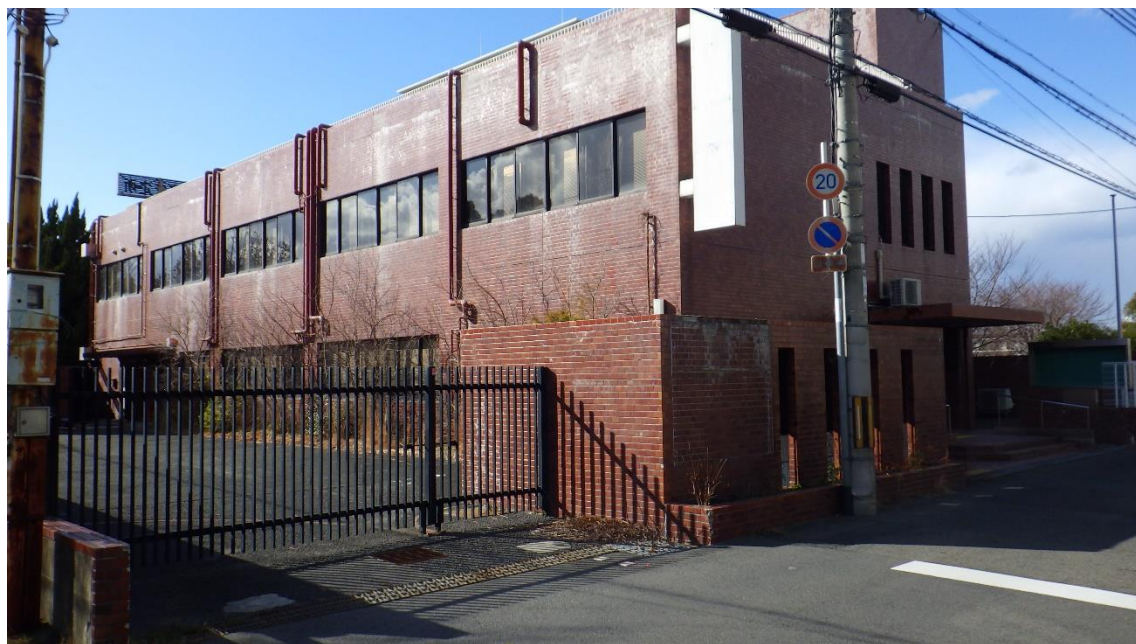
①旧ハローワーク（東方より）
