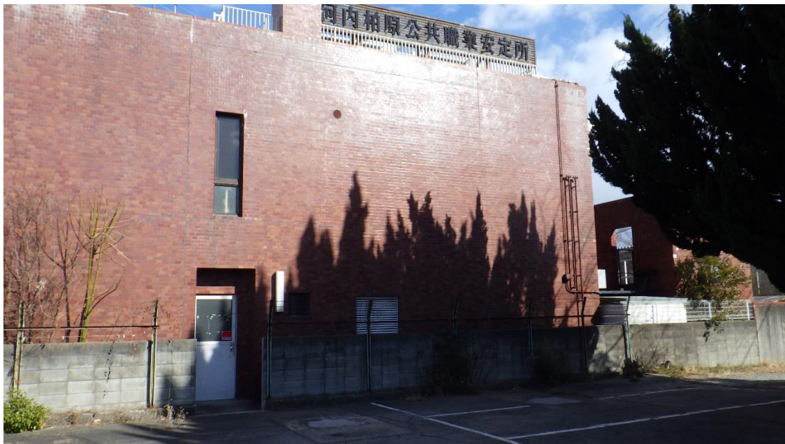
③旧ハローワーク（西方より）
